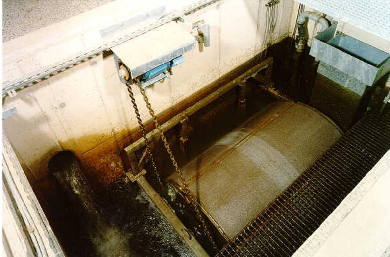
**Figure 5:** *Filtre à tambour rotatif de la station de Bullange (France)*
