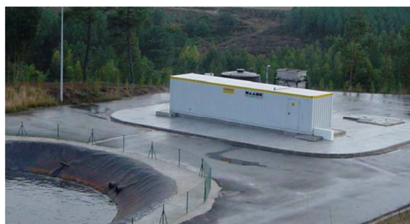
Figure 35 : Photo d'une configuration typique d'une installation d'osmose inverse à 2 étages avec lagunage aéré des lixiviats, rejet direct du perméat et ré-infiltration du concentrat (120 m 3 /j, CSDU de Rebat à Amarante, Portugal, mise en service en 2001)
