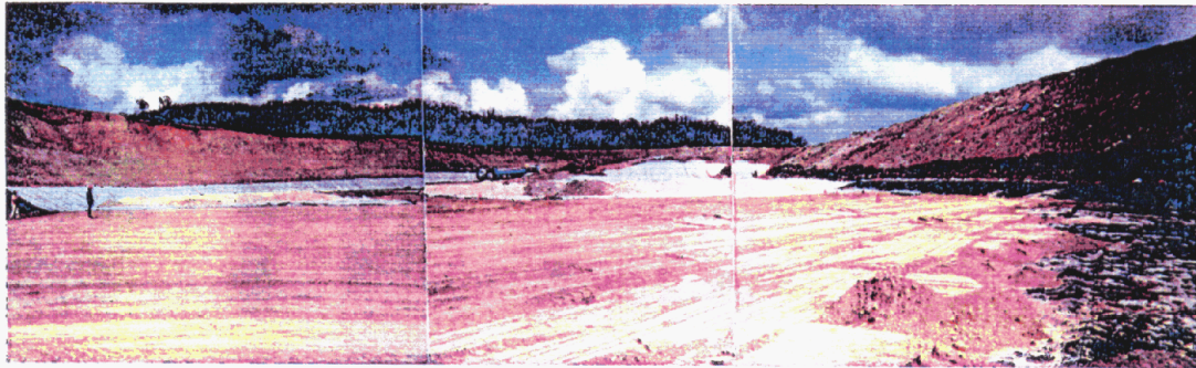
Photographie 8 : Alvéole du CET de X avec géomembrane de soubassement et couche de matériaux de protection.
