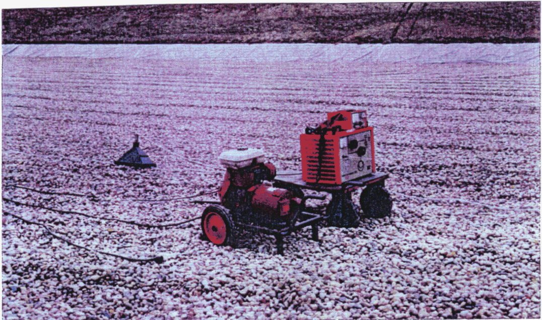
Photographie 12 : Vues sur l'alimentation en Hélium et la source d'énergie.
