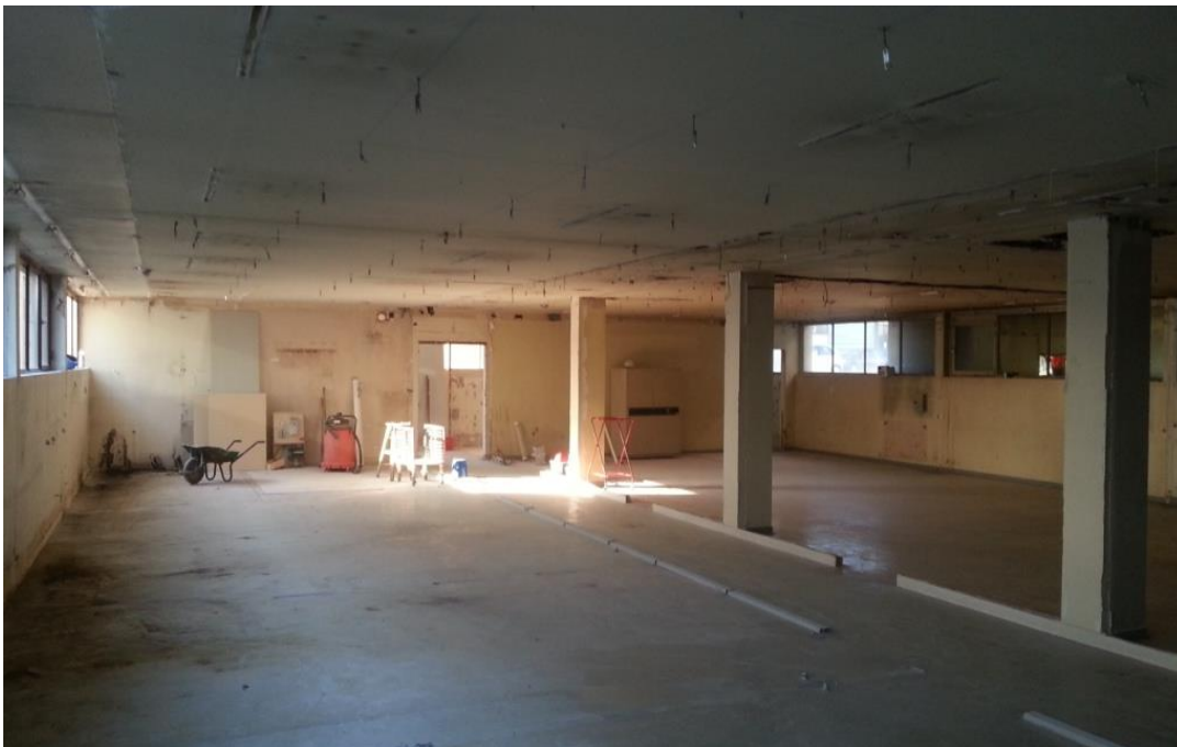
Figure 42 Zone curée prête pour les opérations de désamiantage (Source : SERPOL)
