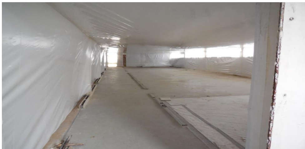
Figure 45 Isolement avec bâche thermo soudée (Source : SERPOL)
