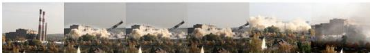
Figure 35 Abattage à l'explosif des cheminées de la centrale de Richemont ( Source : EDF )
