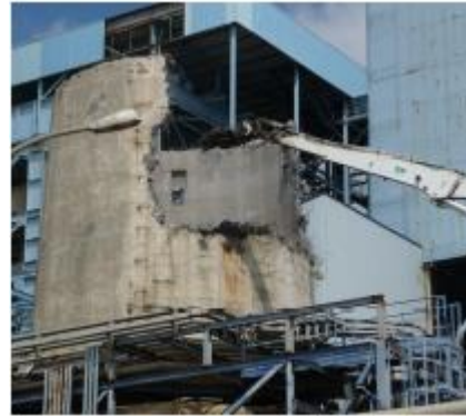
Figure 36 Grignotage des cheminées de la centrale de Cordemais (Source : EDF)
