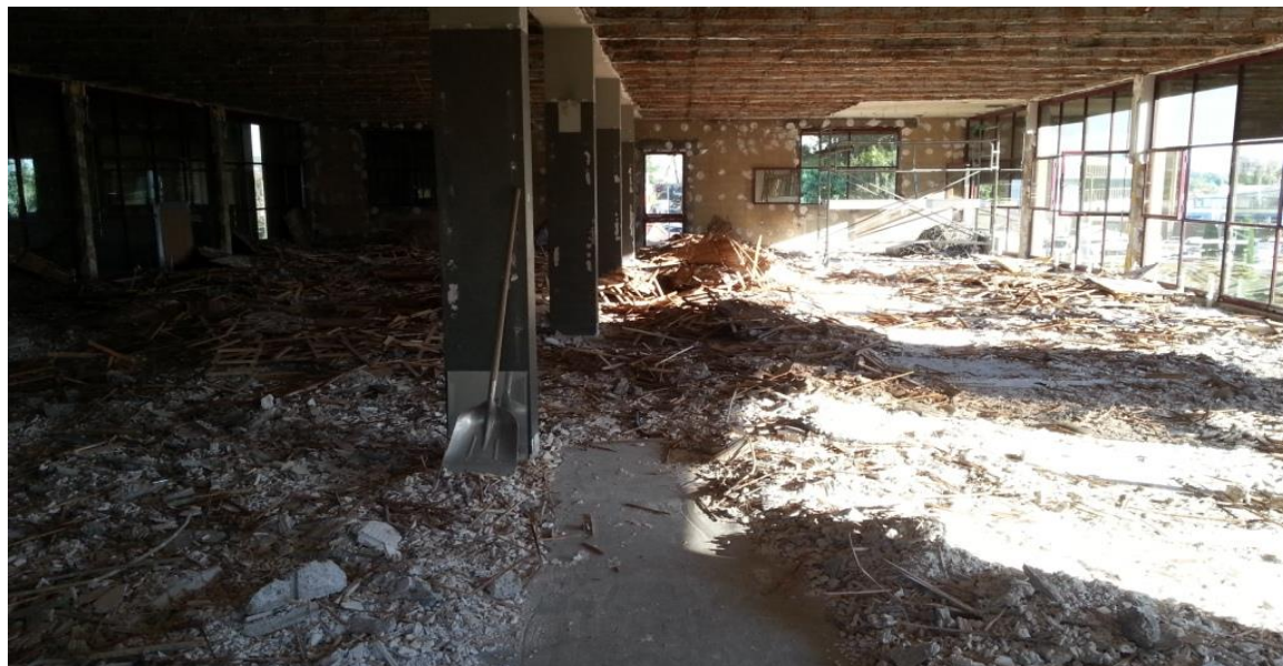
Figure 41 Le chantier de déconstruction réalisé par SERPOL (Source : SERPOL)
