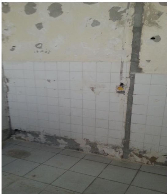
Figure 44 Double couche de faïence (Source : SERPOL)
