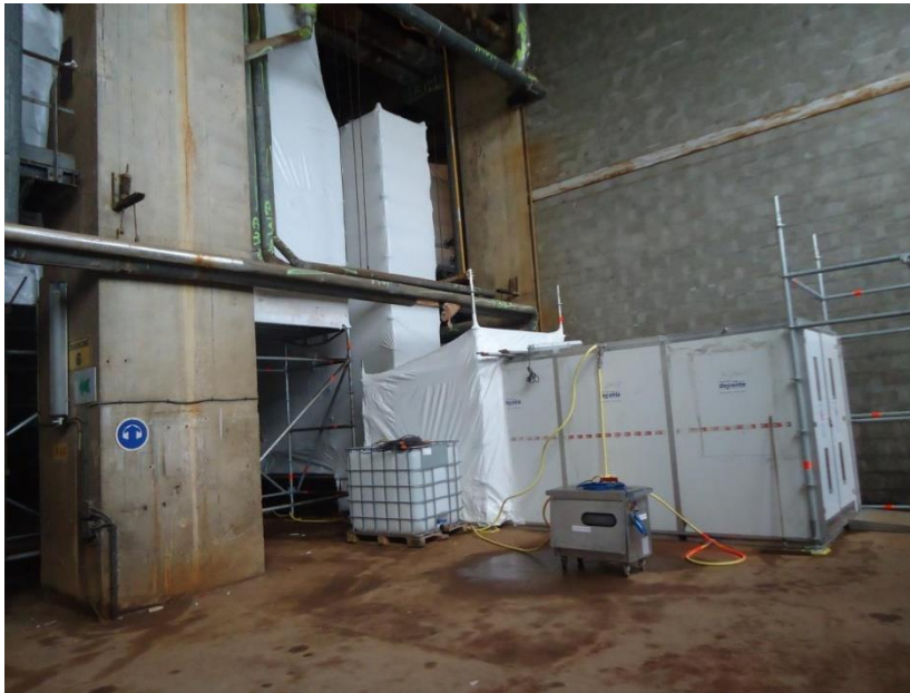
Figure 37 Exemple de sas de confinement des ouvrages à désamianter (Source : EDF)
