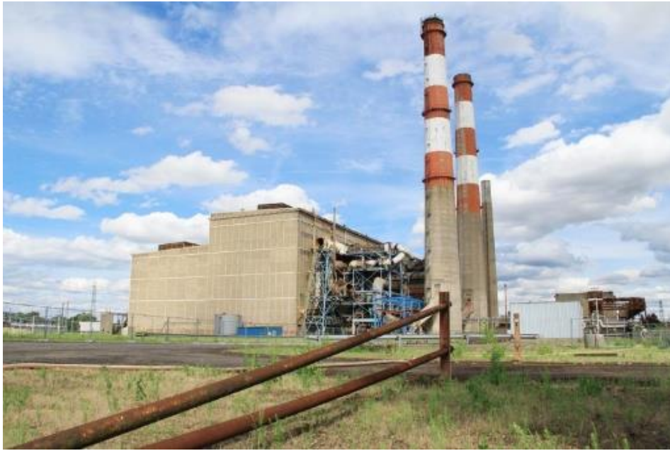
Figure 33 Vue d'ensemble du site de la Centrale Thermique de Richemont (Source : EDF)
