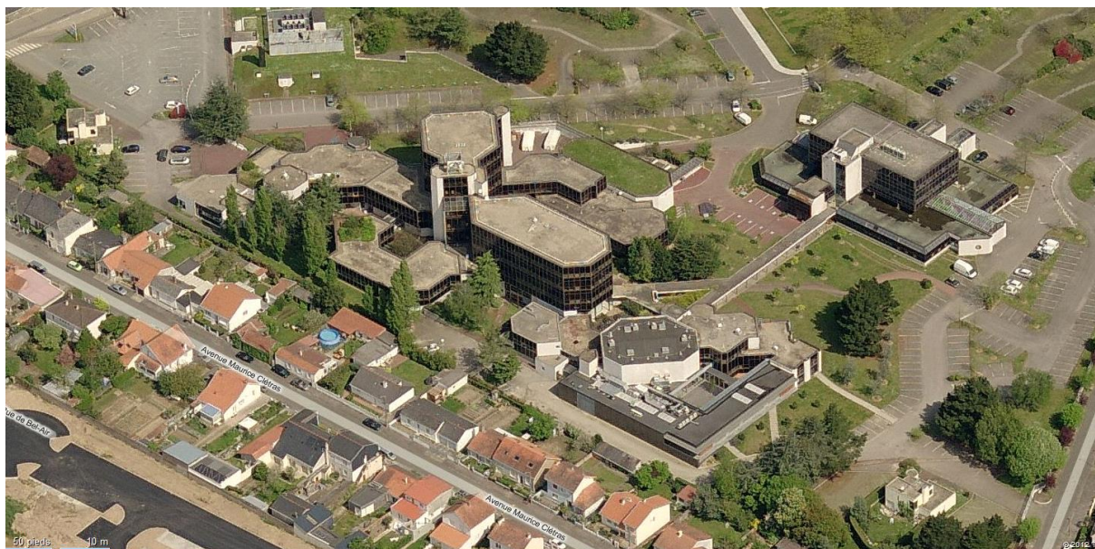
Figure 38 Vue d'ensemble du site du Crédit Agricole (Source : OCCAMAT)
