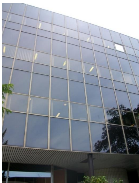
Figure 39 Détail d'une façade (Source : OCCAMAT)
