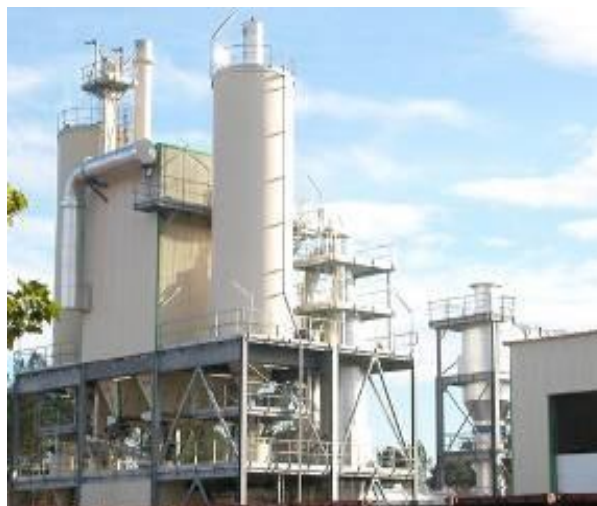
Figure 70 Photo de l'usine INERTAM (Morcens-33)
