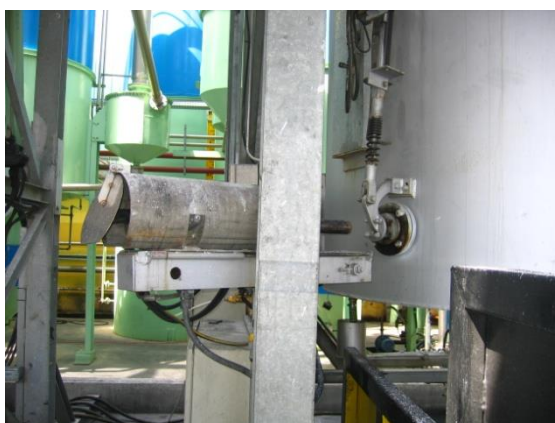
Figure 36 : Brûleur GPL disposé en partie basse du réacteur
