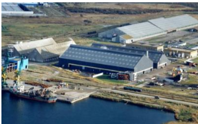
Figure 42 : Installation Citron, au Havre
