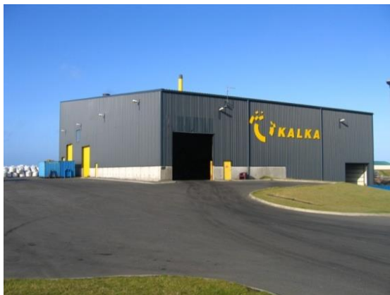
Figure 84 : Installation de Reykjavik
