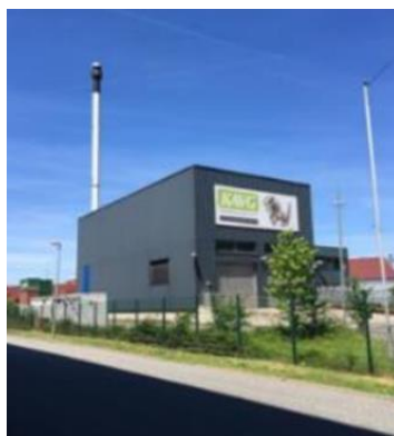
Figure 101 : Installation KAVG à Minden (fonctionnement au RDF)
