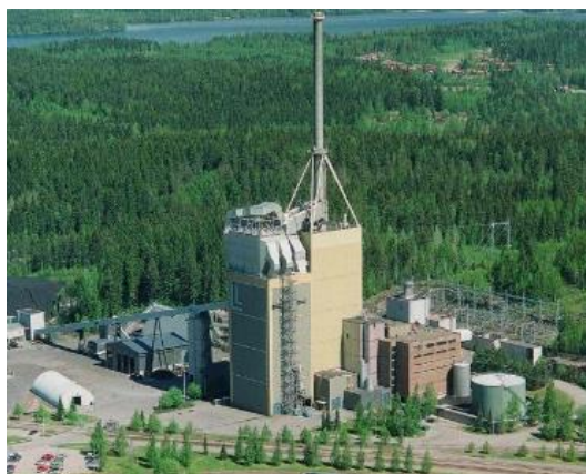
Figure 88 : Unité de cogénération de Lahti
