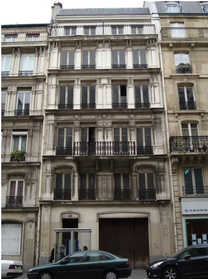
Figure 14. Façade de l'immeuble du 145 rue Lafayette à Paris (d'après [23]).
