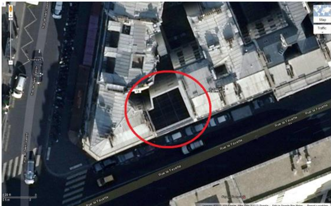
Figure 15. Grilles de ventilation dissimulées derrière la façade de l'immeuble du 145 rue Lafayette à Paris (d'après [23]).
