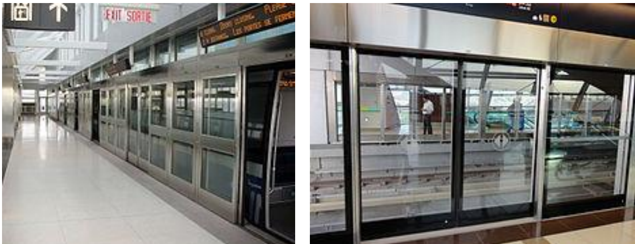
Figure 38 : Photo de stations équipées d'un PSD (platform screen door) toute hauteur à gauche : métro de Toronto et à droite : métro de Dubaï
