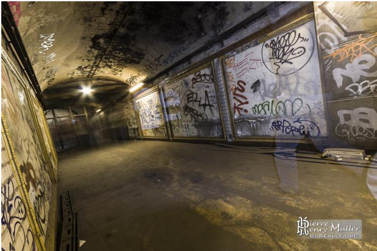
Figure 11. Des couloirs de la station fantôme "Croix-Rouge" utilisés pour la ventilation de la ligne 10 du métro de Paris (d'après [19]).
