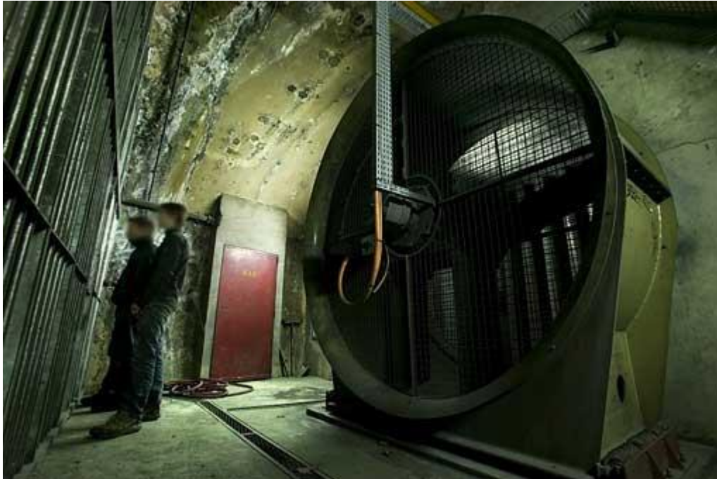
Figure 9. Ventilateur dans le métro de Paris (d'après [17]).
