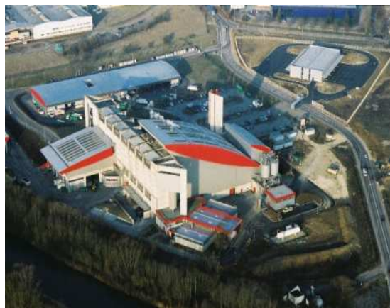
Figure 1 : centre de valorisation des déchets de Ludres (source : Nancy Energie)
