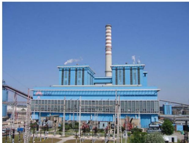
Figure 56: Photo du site de ENEL Fusina "Andrea Palladio" (ENEL, 2017)
