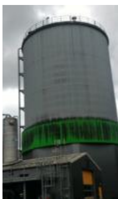
Figure 36: Unité de digestion anaérobie (RECORD, 2018)
