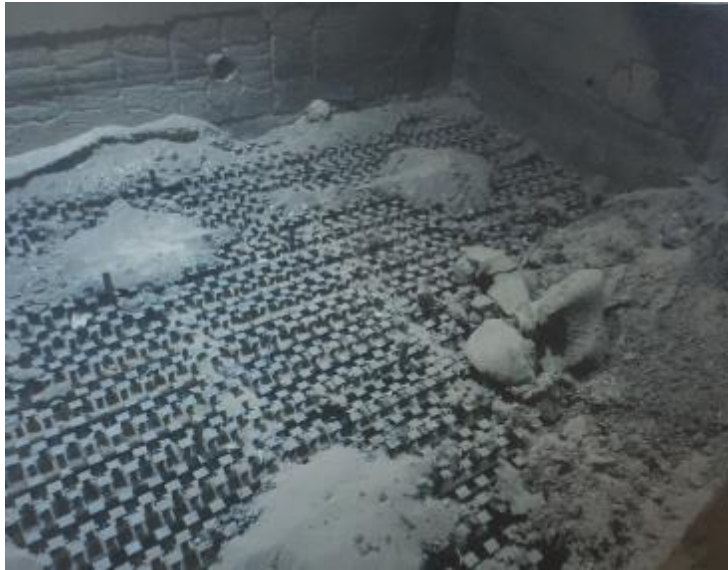
Figure 93 - Photo du lit avant le nettoyage (problème d'encrassement) (Stora Enso, 2017)
