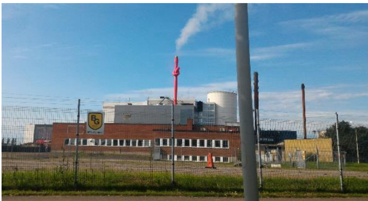
Figure 115: Installation dédiée à la combustion de RDF de Landskrona Energie (RECORD, 2018)
