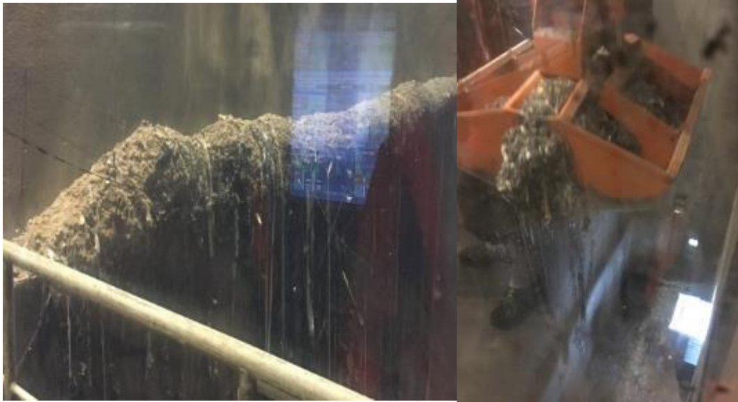
Figure 114 : RDF dans l'aire de stockage (RECORD, 2018)
