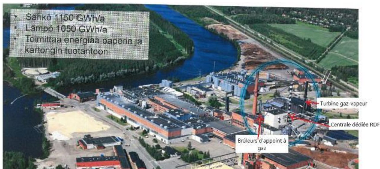
Figure 87 - Papeterie- Trois usines produisent de la chaleur (compilation RECORD, 2018) (Stora Enso, 2017)
