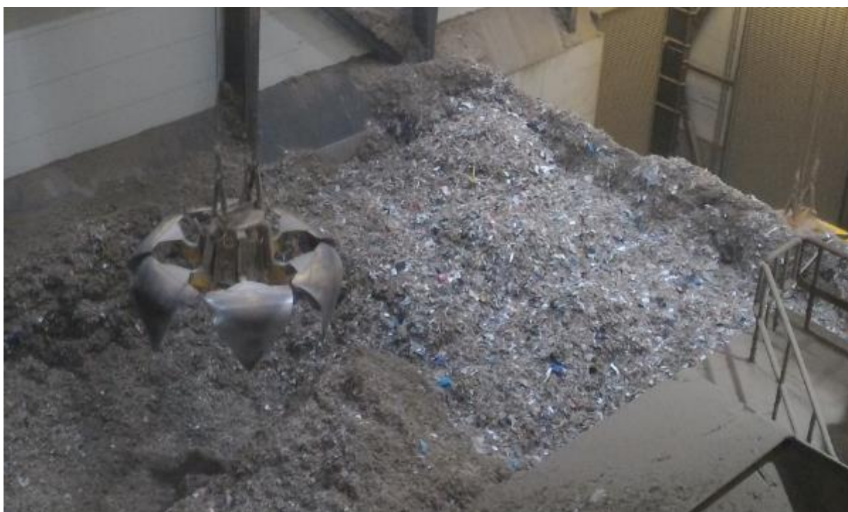
Figure 117 : Aire de stockage des RDF (RECORD, 2018)
