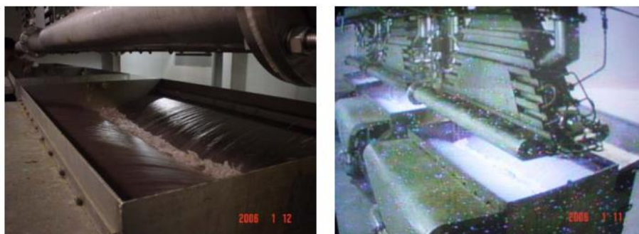
Photo 7. Installation industrielle de faisceaux d'électrons de l'unité de Daegu [209]
