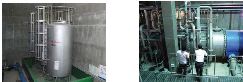
Photo 1. Wedeco MiPRO™ eco3 avec le poste d'injection de \text{H}_2\text{O}_2 (gauche) et la ligne d'injection d'ozone de 17 000 m 3 /h (gauche) [67]
