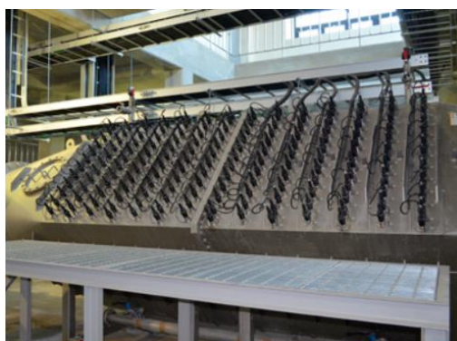
Photo 3. Réacteur d’irradiation d’UV (3500 J/m 2 , 4419 m 3 /h) du procédé Wedeco MiPRO™ couplant H 2 O 2 /UV [83]
