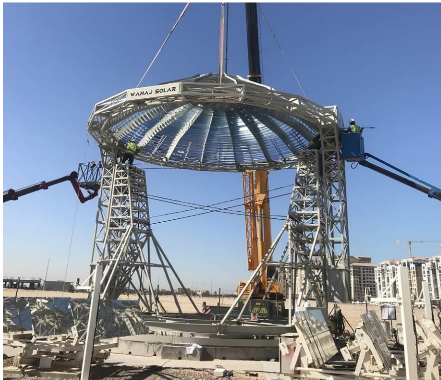
Figure 194 - Concentrateur solaire pilote pour la production de H2 aux EUA, source Wahaj Solar, 2020
