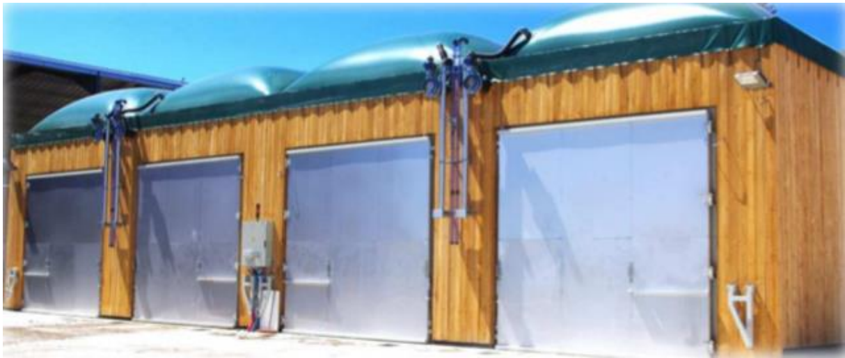
Figure 16 – Installation type garage, Crédit Naskéo Méthajade en Côte d'Or
