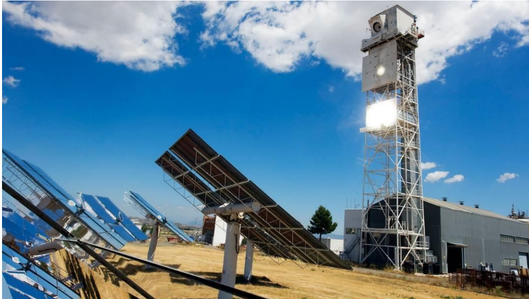
Figure 193 - Vue du site pilote pour le projet hydrosolplant- Source projet HYDROSOL, solarpaces Le TRL de cette technologie est de 4-5
