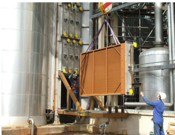
Mise en place dans cheminée
