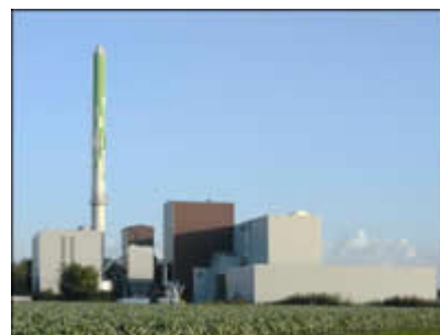
Figure 12 : Installation ORC de 2,5 MWe de TURBODEN sur des excédents du réseau de chaleur de l'incinérateur de déchets MIROM, Roeselare (Roulers)
