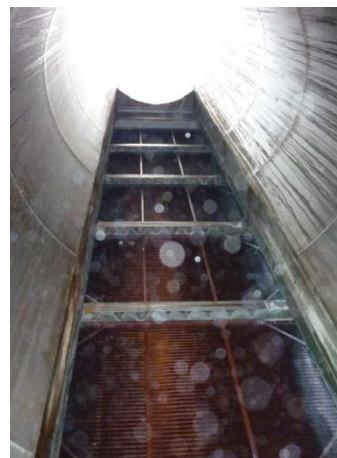
Vue intérieur cheminée
