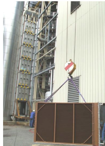
Montage sur site des batteries
