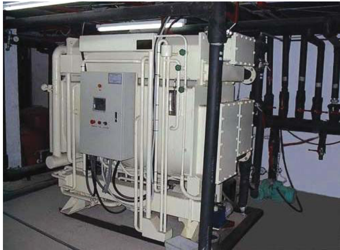
Figure 5 : Machine à absorption – Hôtel de Rethymnon – Crète (Grèce)
