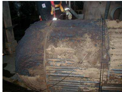
Figure 19 : Echangeurs à tubes et calandre ayant subi des encrassements
