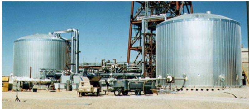
Stockage de chaleur à SOLAR : Ces 2 réservoirs de sel fondu permettent une production électrique de pleine puissance pendant 3 heures sans soleil
