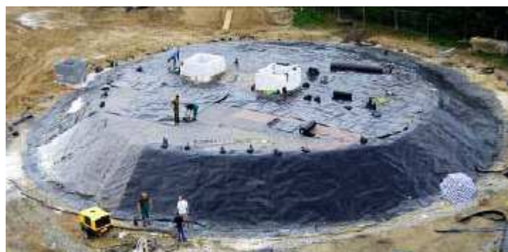
Figure 11' : photo aérienne de la réalisation du stockage GWTES à Eggenstein[5]
