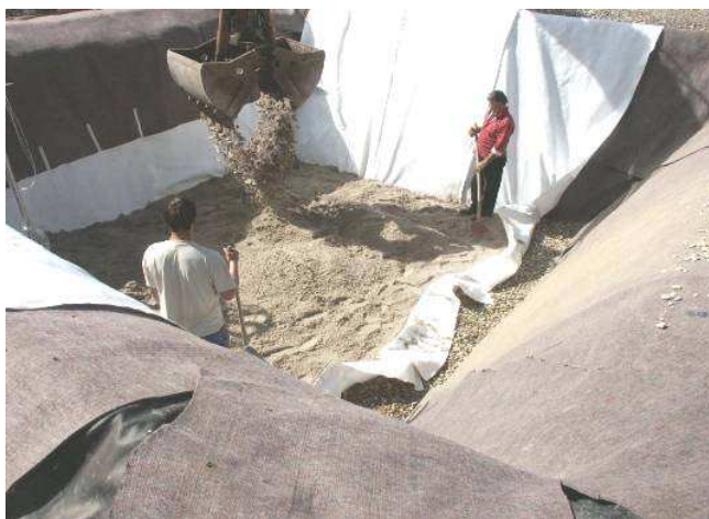
Figure 10 : La construction du stockage ; côté gauche: le remplissage de la couche de sable côté droite : côté enveloppant la couche de sable en géotextile (laine), afin d'éviter éluviation (décantation); sur le côté droit du stockage la couche de gravier vertical peut être observé
