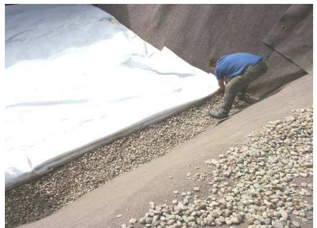
Figure 10 : La construction du stockage ; côté gauche: le remplissage de la couche de sable côté droite : côté enveloppant la couche de sable en géotextile (laine), afin d'éviter éluviation (décantation); sur le côté droit du stockage la couche de gravier vertical peut être observé
