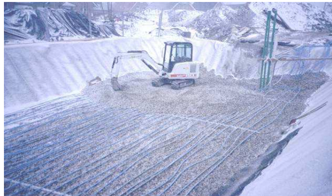
Figure 9 : Vue de la construction d'un stockage de chaleur avec échangeur en serpentin[4]
