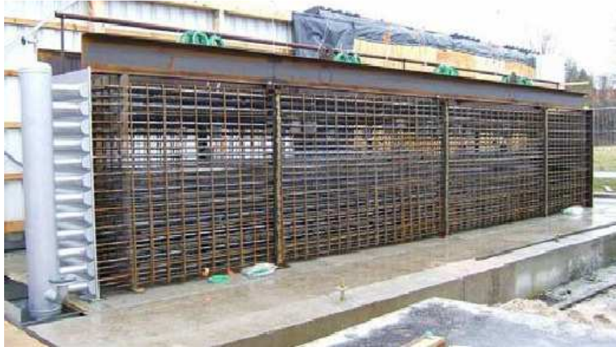
Figure 3 : Vue du faisceau de tubes du prototype du DLR et de l'armature
