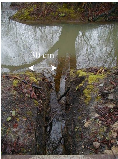
Figure 7 : Photographie de l'ancien siphon
