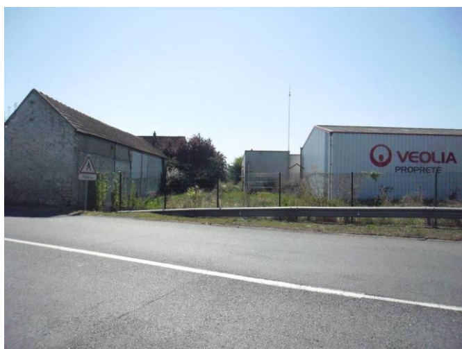
Figure 29: vue en direction du bâtiment des fosses depuis l'emplacement 2
