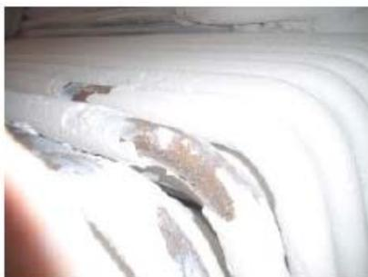
**Figure 6 : Dépôts sur des tubes d'échangeur**
