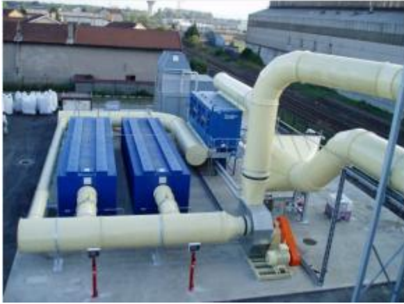
Exemple d'insertion de filtre à charbon actif sur site (Source : DESOTEC)
