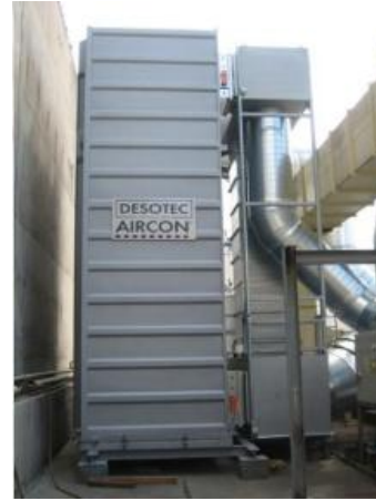
Exemple d'insertion de filtre à charbon actif sur site (Source : DESOTEC)
