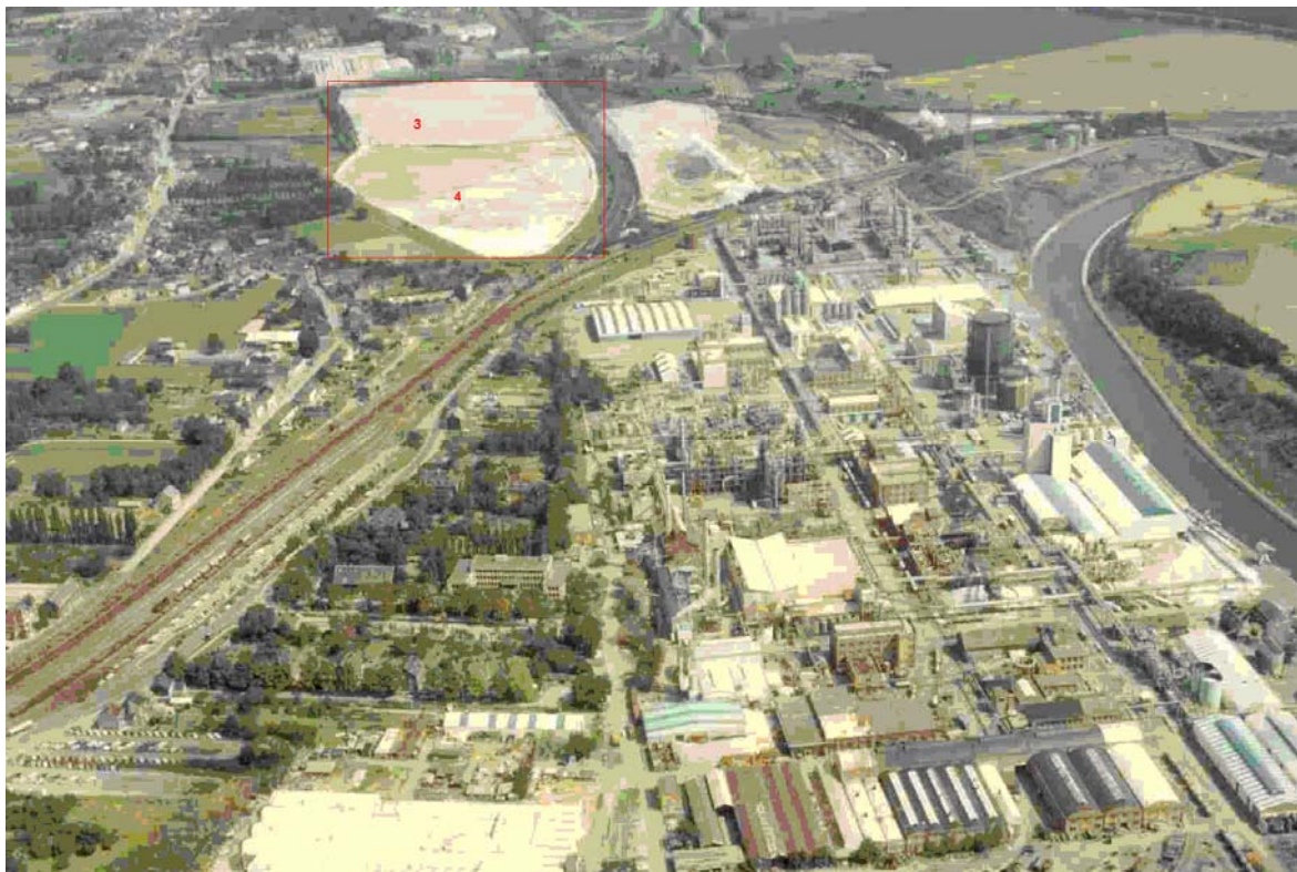
Figure 7 : Vue aérienne des bassins de décantation 3 et 4 du site expérimental.
