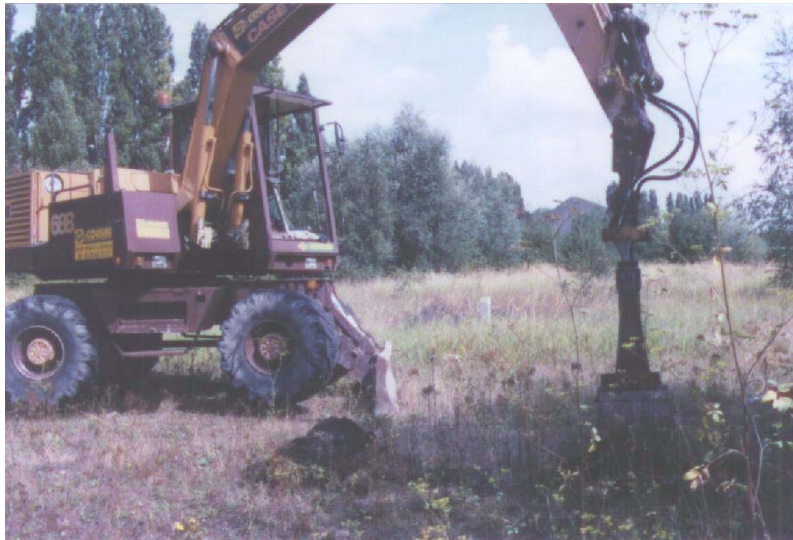
Figure 4 : Ouverture de fosses à la pelle mécanique
