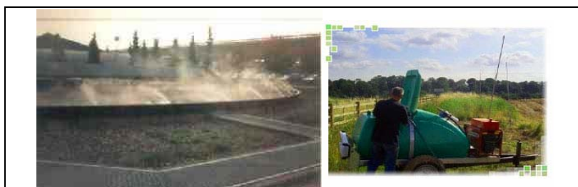
Figure 10-1: Illustration d'un système fixe (ECOSORB) et mobile (ECO TECHNOLOGY)
