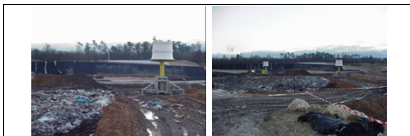
Figure 10-4: Dispositif Eolage sur un site de stockage de déchets (Photos du site Internet Delamet).
