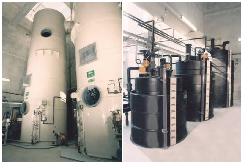
Figure 9.3.5 : Tours de lavage et cuves à réactifs de la station d'Arbouans
