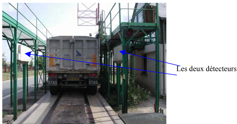
Figure 2 : Photo d'un portique en entrée de centre de traitement de déchets pour le contrôle d'un camion.
